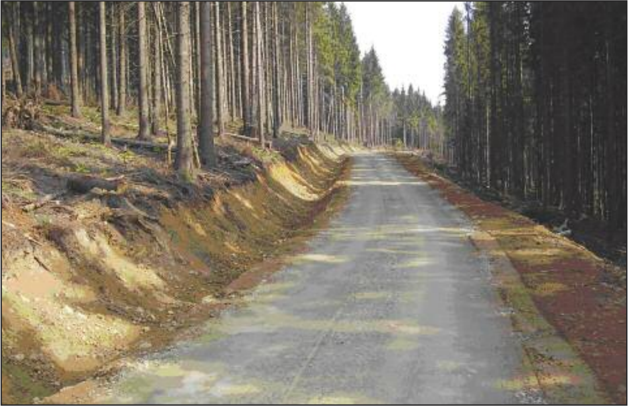
Obrázek 3.13.1 Odvozní lesní cesta třídy II L vybavena štěrkovou vozovkou
